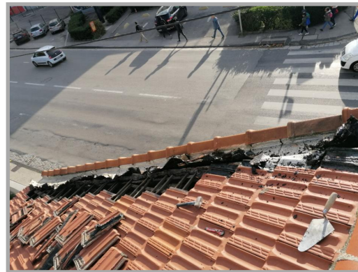
Toiture de la salle paroissiale de Pont de Vivaux novembre 2019
