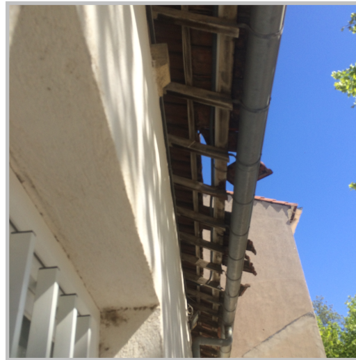
Toiture du Bd Queirel mai 2019
